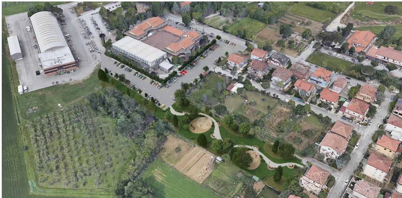
Vista aerea dell'intervento da Ovest
