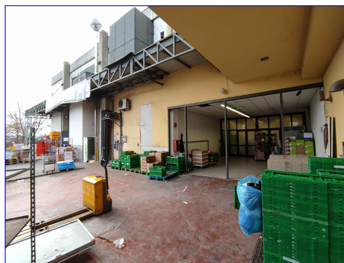
FOTO 4 Vista sul portico oggetto dell'ampliamento di area di vendita del Conad "Boschetto"
