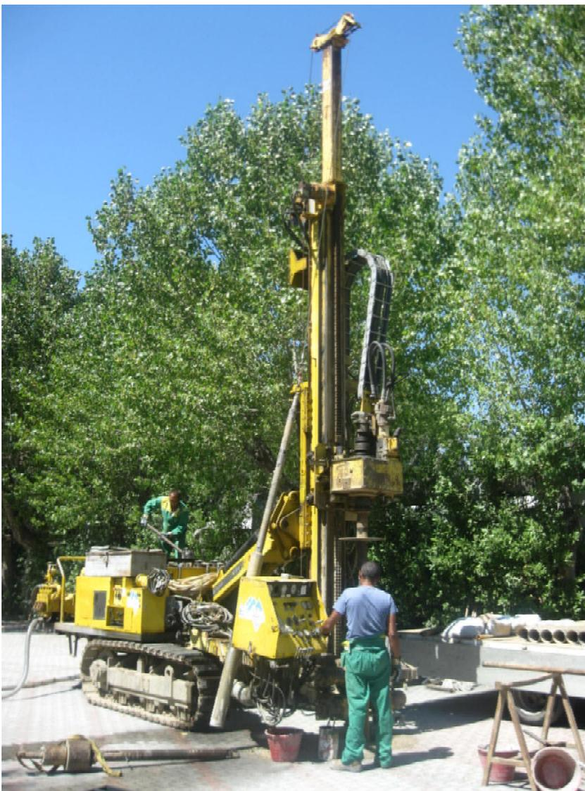
*Figura 5: Esecuzione sondaggio geognostico S1*
