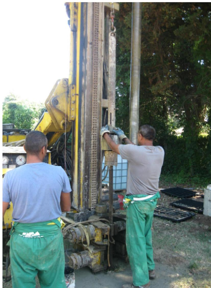
*Figura 6: Esecuzione prova SPT in corrispondenza del sondaggio S2*
