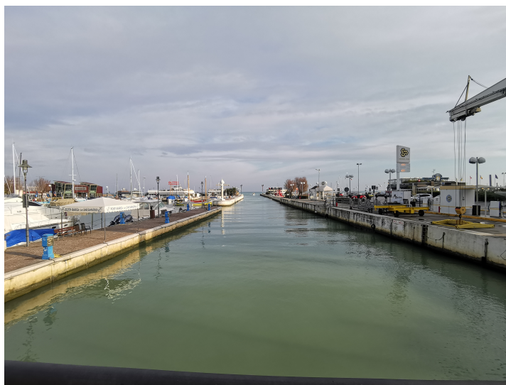
Figura 4 vista dal ponte di viale D'Annunzio verso mare
